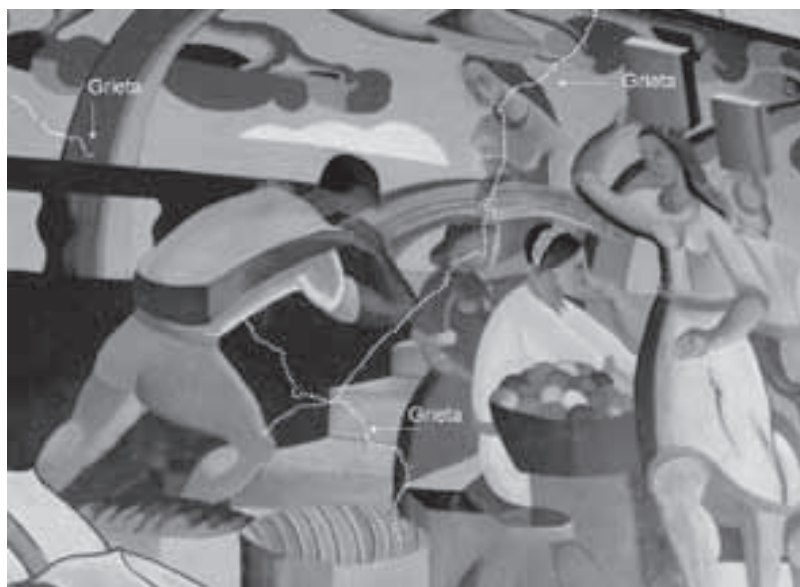
Mural “Feria Libre” de Anarko Bermejo, ubicado en el Internado de Hombres de Los Ángeles. El sismo provocó agrietamientos superficiales sin riesgo de desprendimiento.
