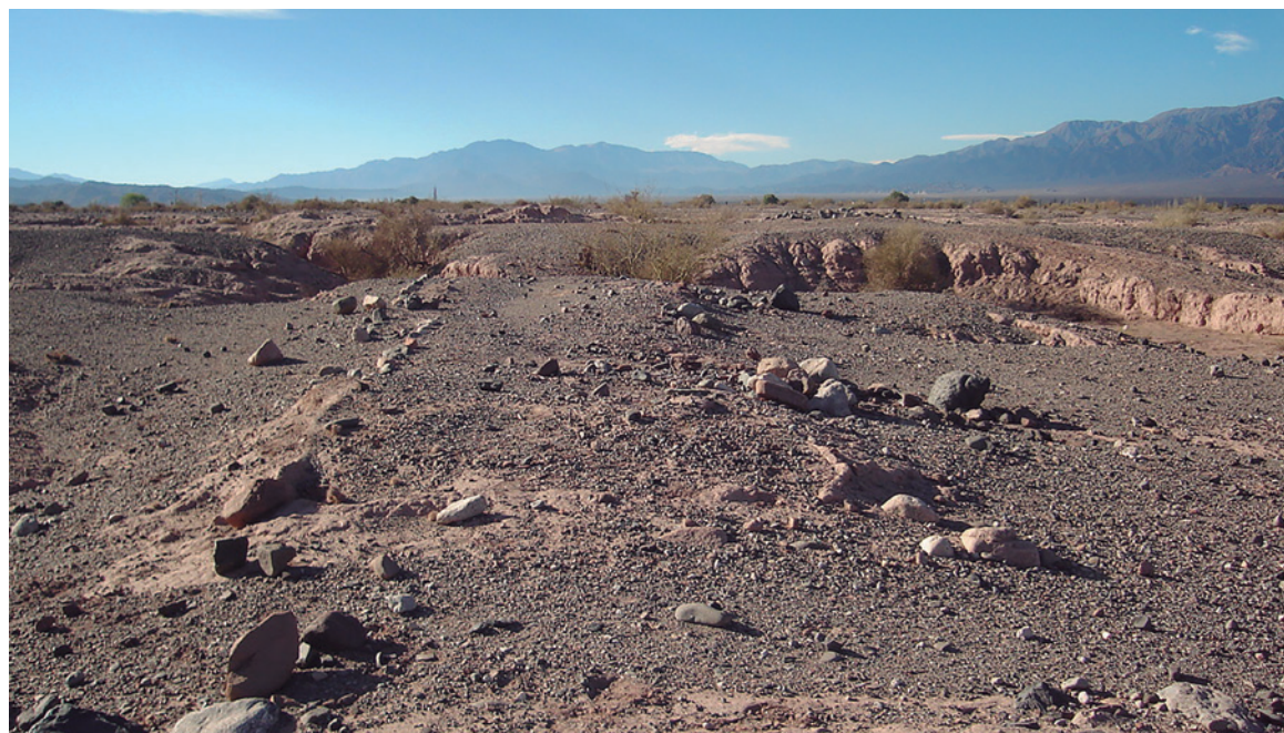
Figura 7. Estructura arquitectónica con cimientos de piedra de época incaica. Se advierte su destrucción casi completa. Al fondo de la imagen se observa una gran torrentera que atraviesa el área (Fotografía: Carosio, S. 2007).
