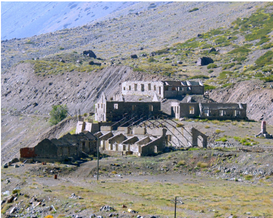
Figura 2. Núcleo central de la estación Hermanos Clark, en el que se evidencia el deterioro de las estructuras (Fotografía: Urzúa, C. 2016).
