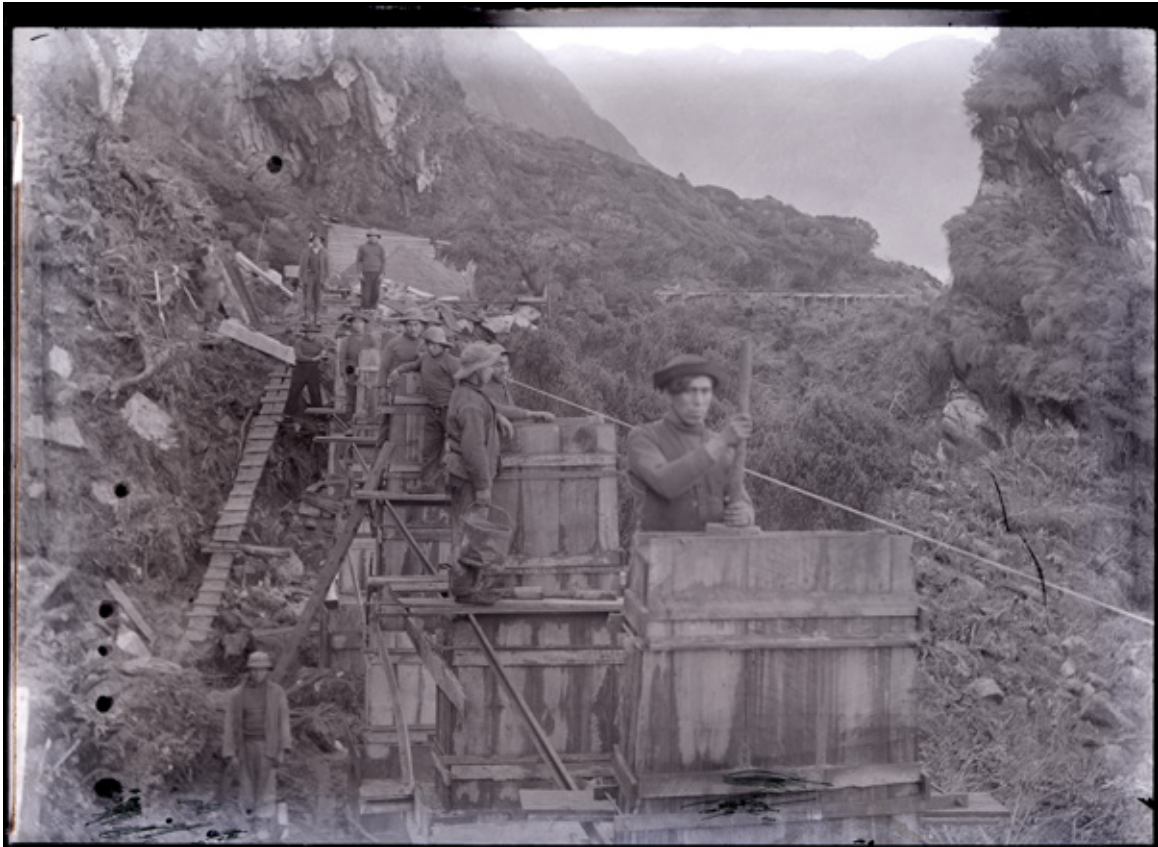
Figura 4. Imagen final después de la limpieza digital y recuperación de la gama tonal, sin modificar su dominante de color original. Se eliminaron rayas, manchas y pelusas que no alteraran la información original en la imagen (Fotografía: Slight, G. Ca 1895-1914. Edición y recuperación digital: Roubillard, M., Ormeño, L., Pérez, T. 2017. Archivo CNCR). Final image after digital cleaning and recovery of tonal range, without modifying its original dominant color. Scratches, spots and lint that did not alter the original information in the image were removed. (Photograph: Slight, G. Ca 1895-1914; digital edition and recovery: Roubillard, M., Ormeño, L., Pérez, T. 2017. Archive CNCR). Imagem final após a limpeza digital e recuperação da faixa tonal, sem modificar sua cor dominante original. Listras, manchas e fiapos foram removidos, o que não alterou as informações originais da imagem. (Fotografia: Slight, G. Ca 1895-1914. Edição digital e recuperação: Roubillard, M., Ormeño, L., Pérez, T. 2017. Arquivo CNCR).
