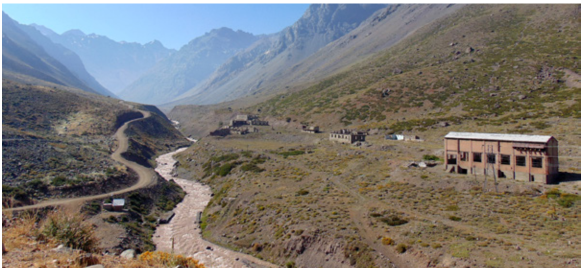
Figura 1. Panorámica de la estación Hermanos Clark, emplazada en el valle del río Juncal, comuna de Los Andes, región de Valparaíso, Chile (Fotografía: Urzúa, C. 2016).
