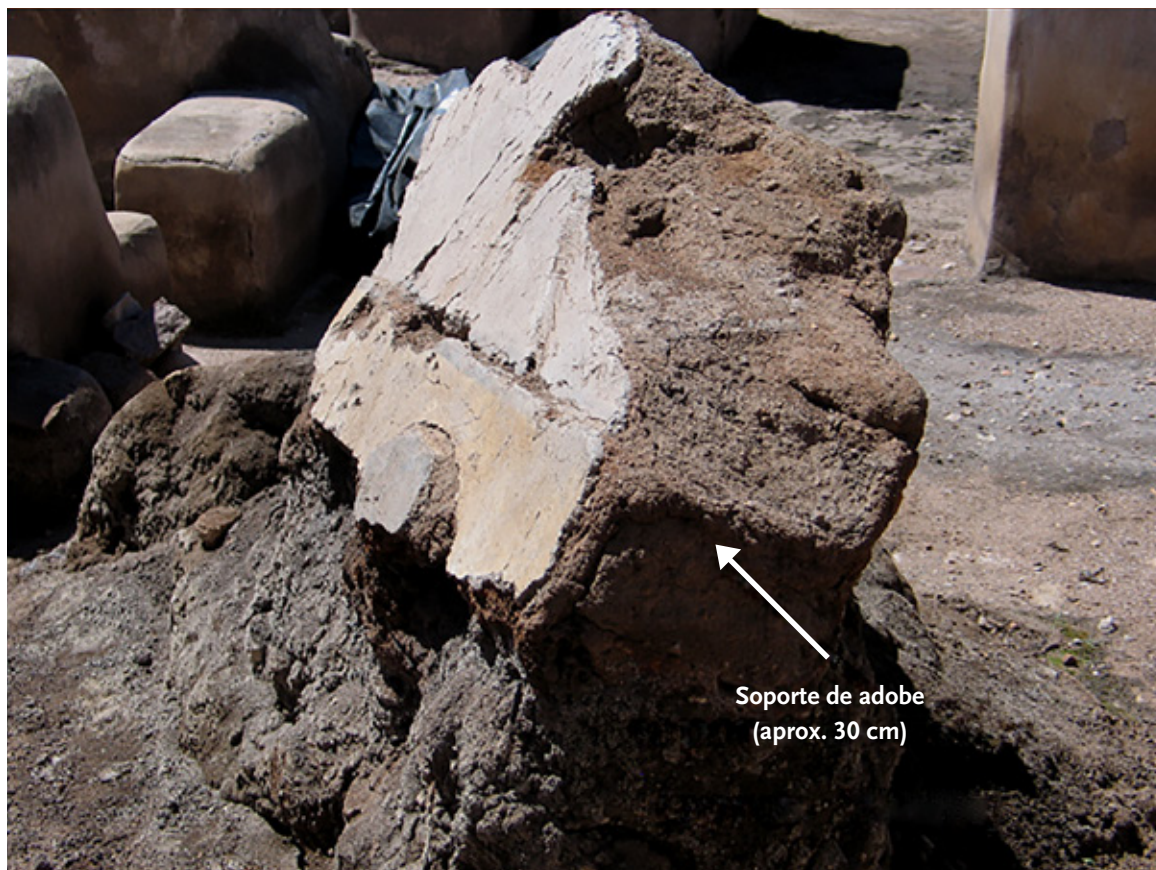
Figura 4. Vista lateral del relieve Picacho Pelón: se aprecian agrietamientos, desprendimientos y pérdida de policromía (Fotografía: Archivo STCA, ENCRyM-INAH, 2009). Side view of Picacho Pelón relief. Cracks, loose parts and polychromy losses can be seen (Photograph: STCA, ENCRyM-INAH Archive, 2009). Vista lateral do relevo Picacho Pelón: apreciam-se rachaduras, desmoronamentos e perda de policromia (Fotografia: Arquivo STCA, ENCRyM-INAH, 1990).
