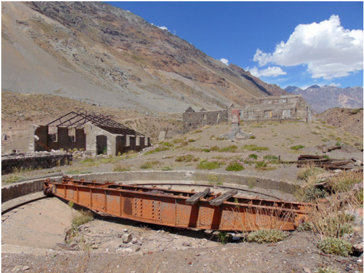
Figura 3. Estación Hermanos Clark. De abajo hacia arriba: tornamesa, casa de máquinas, monolito Hermanos Clark y edificio de la estación. Se aprecia la fuerte pendiente del macizo cordillerano (Fotografía: Urzúa, C. 2016).
