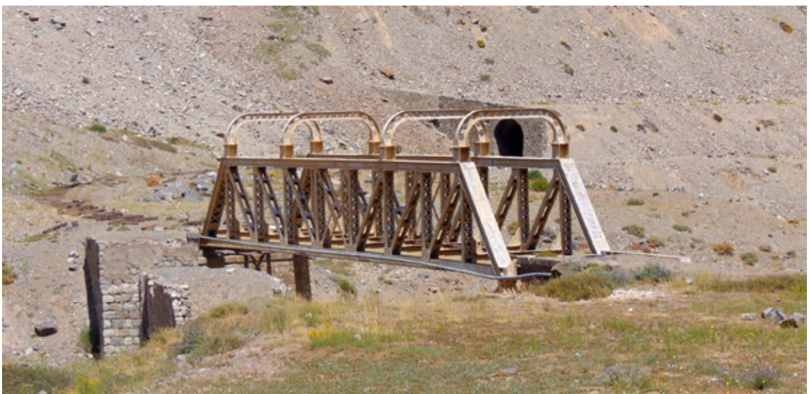
Figura 8. Puente en el km 55,4 de la vía que cruza el río Juncal. En segundo plano, se aprecia uno de los túneles del margen sur del valle (Fotografía: Urzúa, C. 2016). Bridge at km 55,4 of the road that crosses the Juncal river. In the background is one of the tunnels on the south side of the valley (Photograph: Urzúa, C. 2016). Ponte no km 55,4 da estrada que atravessa o rio Juncal. Em segundo plano, aprecia-se um dos túneis da margem sul do vale (Fotografia: Urzúa, C. 2016).
