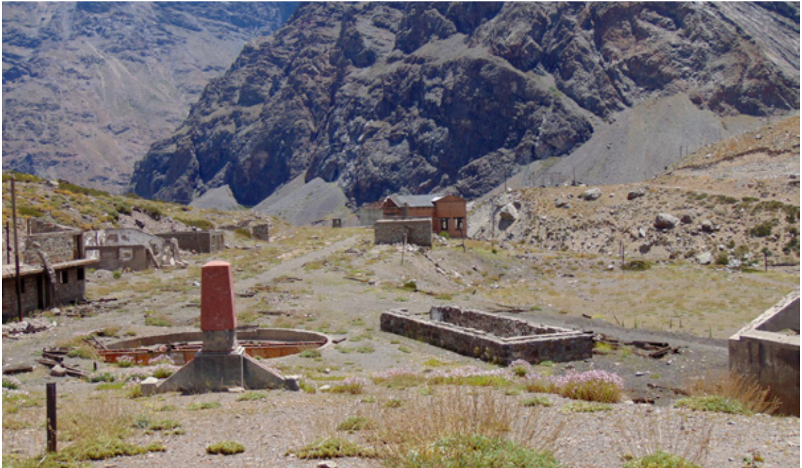
Figura 7. Panorámica de la estación Hermanos Clark desde el edificio de la estación. En primer plano, el monumento a los Clark, estructura de concreto que en su frontis tenía una placa de bronce con el rostro de los hermanos (Fotografía: Urzúa, C. 2016). Overview of Hermanos Clark station from the station building. In the foreground the monument to the Clarks, a concrete structure that had a bronze plaque on its front, with the faces of the brothers (Photograph: Urzúa, C. 2016). Panorâmica da estação Hermanos Clark desde o prédio da estação. Em primeiro plano, o monumento aos Clark, uma estrutura de concreto que tinha uma placa de bronze na frente com o rosto dos irmãos (Fotografia: Urzúa, C. 2016).
