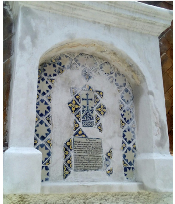
Figura 8. Detallado de nicho: resanes y definición de perfiles previo a la aplicación de pintura (Fotografía: Hernández, A. 2017). Niche detail: repairs and definition of profiles before the application of paint (Photograph: Hernández, A. 2017). Detalhe do nicho: consertos e definição de perfis antes da aplicação da pintura (Fotografia: Hernández, A. 2017).
