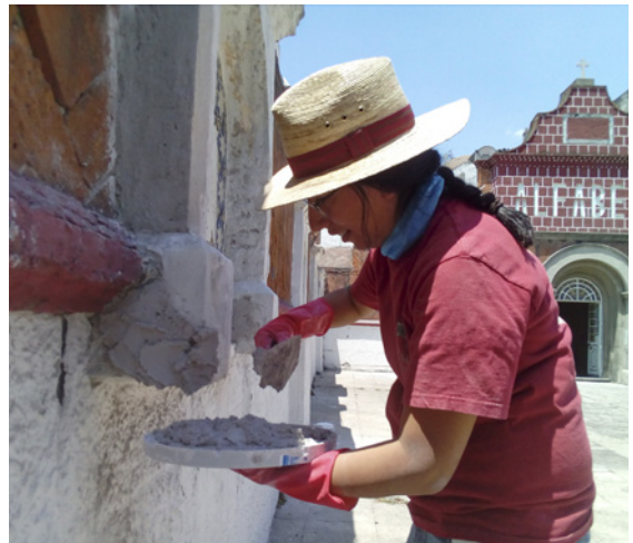
Figura 6. Aplicación de mortero: mezcla cal-arena, proporción 1:3, para recuperación de volumetría y perfil de nicho del Vía Crucis (Fotografía: De La Torre, C. 2017).
