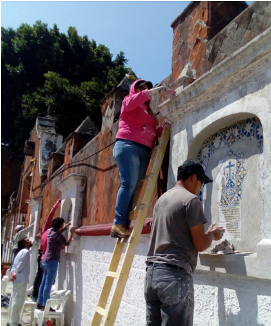
Figura 7. Aplicación de argamasa en diferentes áreas del nicho (Fotografía: Hernández, A. 2017). Application of mortar in different areas of the niche (Photograph: Hernández, A. 2017). Apliação de argamassa em diferentes áreas do nicho (Fotografia: Hernández, A. 2017).
