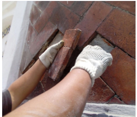
Figura 10. Limpieza de ladrillo rojo, también conocido como petatillo, y reintegración de piezas faltantes (Fotografía: Hernández, A. 2017). Cleaning of red brick, also known as petatillo, and reintegration of missing pieces (Photograph: Hernández, A. 2017). Limpeza de tijolo vermelho, também conhecido como petatillo, e reintegração das peças faltantes (Fotografia: Hernández, A. 2017).
