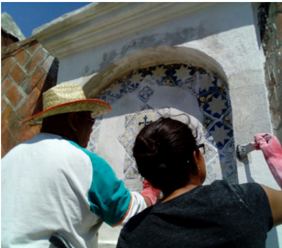
Figura 9. Aplicación de acabado fino: mezcla cal-arena en proporción 1:1 (Fotografía: Hernández, A. 2017). Application of fine finishing: lime-sand mixture in 1:1 ratio (Photograph: Hernández, A. 2017). Apliação do acabamento fino: mistura de cal e areia em proporção 1:1 (Fotografia: Hernández, A. 2017).
